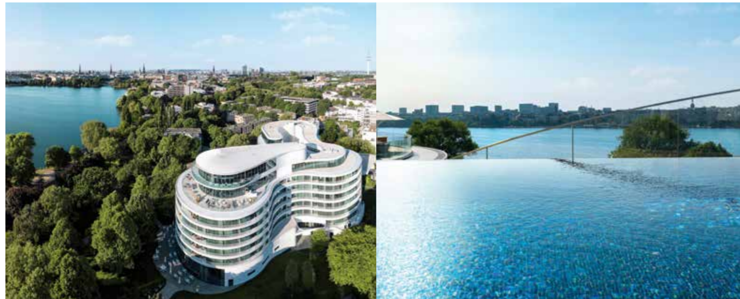
Liegt im Grünen und am Wasser: «The Fontenay» mit seiner geschwungenen Fassade und Infinity-Pool mit Blick über die Aussenalster.
